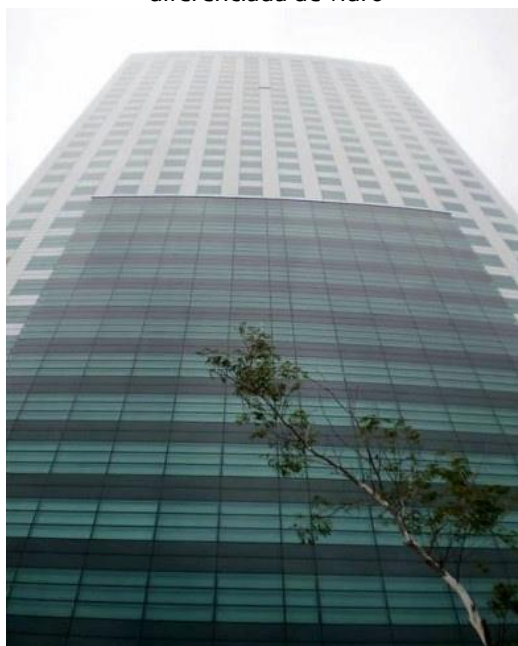
Figura XII: Edif cio Eldorado Business Tower – foto da fachada frontal com a grelha estrutural e vedac o diferenciada de vidro
