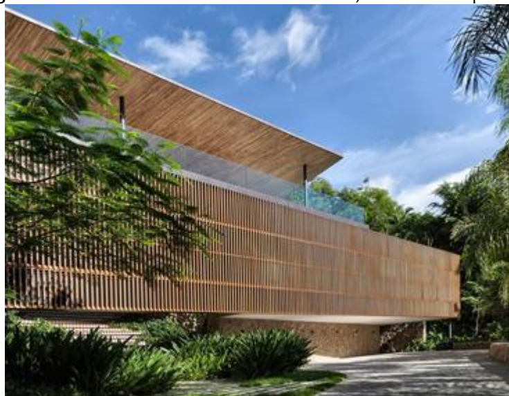
Figura IV - Uso de brises na fachada – Casa Delta, Bernardes Arquitetura
