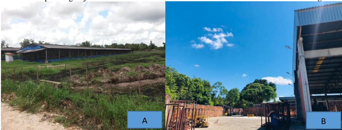
Figura 5. A. Galpão de granja de aves no leito do curso do rio B. Indústria têxtil instalada nas margens do rio.
