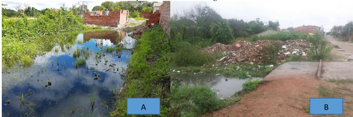
Figura 3. A. Construção de residências em pontos de alagamento às margens do rio Catu. B. Descartes de entulhos para aterramento da margem do rio
