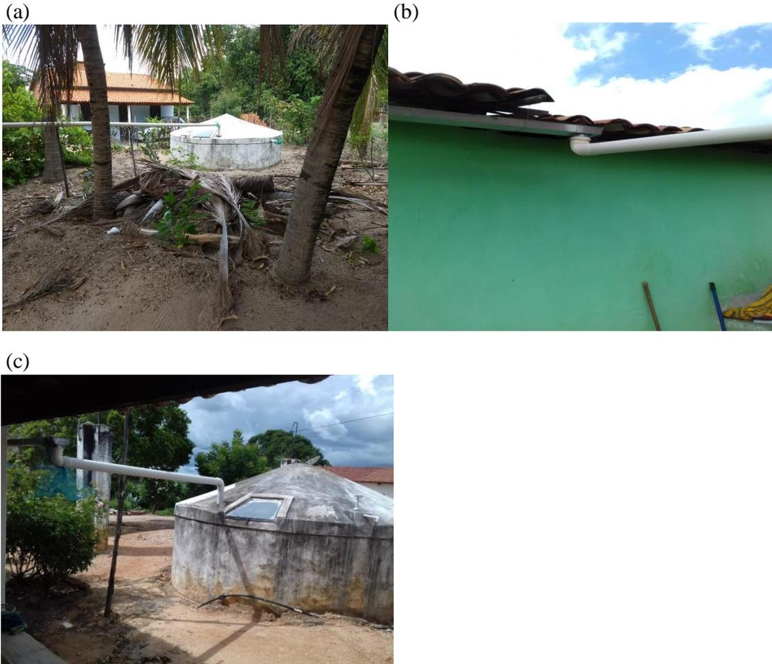
A captação é feita através de calhas que levam a água vinda do telhado até o reservatório (cisterna). No estudo, percebeu-se que há árvores ao redor de uma grande parte das residências, que podem levar à contaminação da água por materiais grosseiros (folhas); observou-se também a queima de resíduos domésticos, que pode causar contaminação pelas cinzas que se acumulam no telhado.
