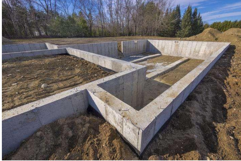
Figura 1 - Fundação feita em concreto
